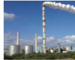
Impianti energia (cogenerazione e solari)
